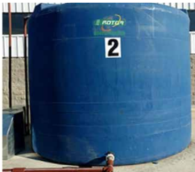
Sistema de recolección de agua de lluvia para uso en lavado de vehículos en Sucursal Rafaela.
