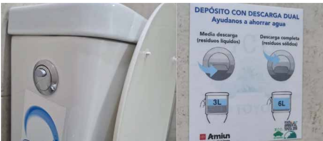
Depósitos de inodoros con descarga dual para ahorro de agua.
