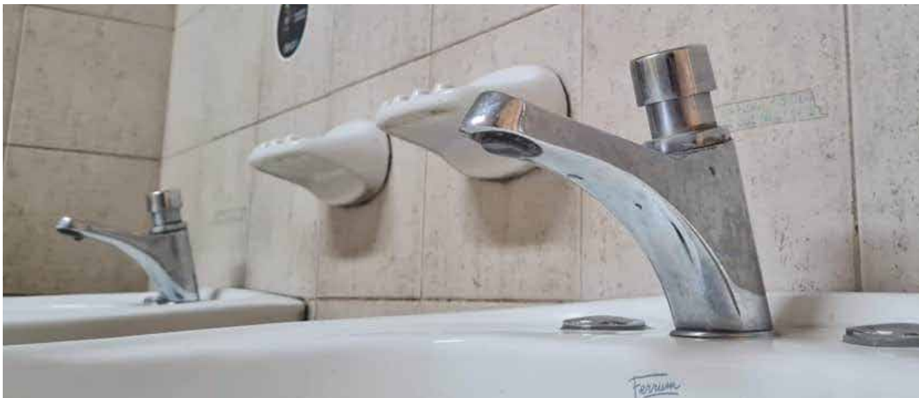
Canillas automáticas en baños en todas las sucursales.
