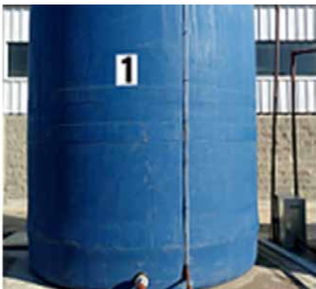
Sistema de recolección de agua de lluvia para uso en lavado de vehículos en Sucursal Rafaela.
